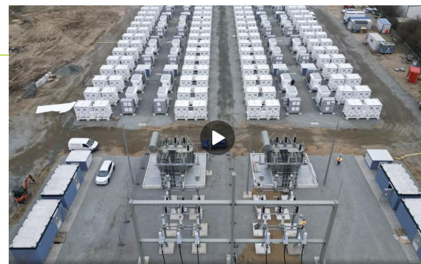
Größter Batteriespeicher in D mit 239 MWh Speicherkapazität => Strom für 30.000 Haushalte für 1 Tag
